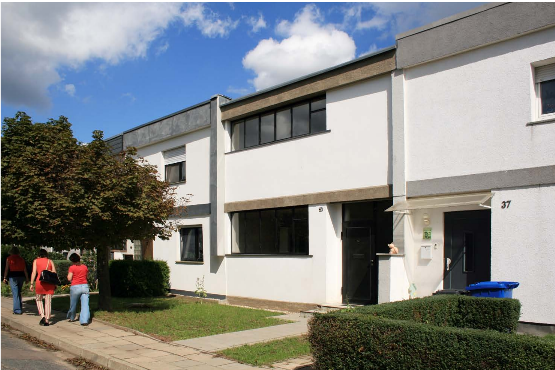
Haus Anton ist als einziges Haus des Typs Sietö 1 weitestgehend im Originalzustand erhalten. Die Nachbargebäude zeigen, wie unterschiedlich die Farben Grau und Weiß ausgelegt werden können. Die Querwände enden auf Höhe der unteren Fensterbrüstung. Gemeinsam mit den Fensterbändern wird so die horizontale Charakteristik optisch betont. (Foto: Yvonne Tenschert, 2010, Stiftung Bauhaus Dessau)
