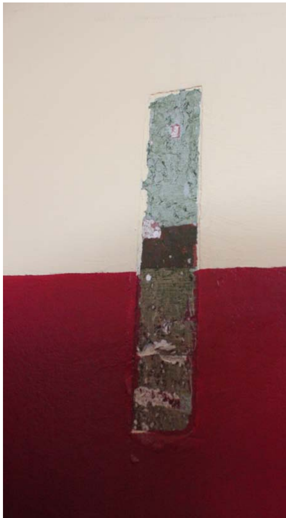
Im Zuge der Renovierung, die im Jahr 1992 vorgenommen wurde, legte man die ursprünglichen Anstriche in den Wohnungen frei. (Fotos: Myrta Köhler)
