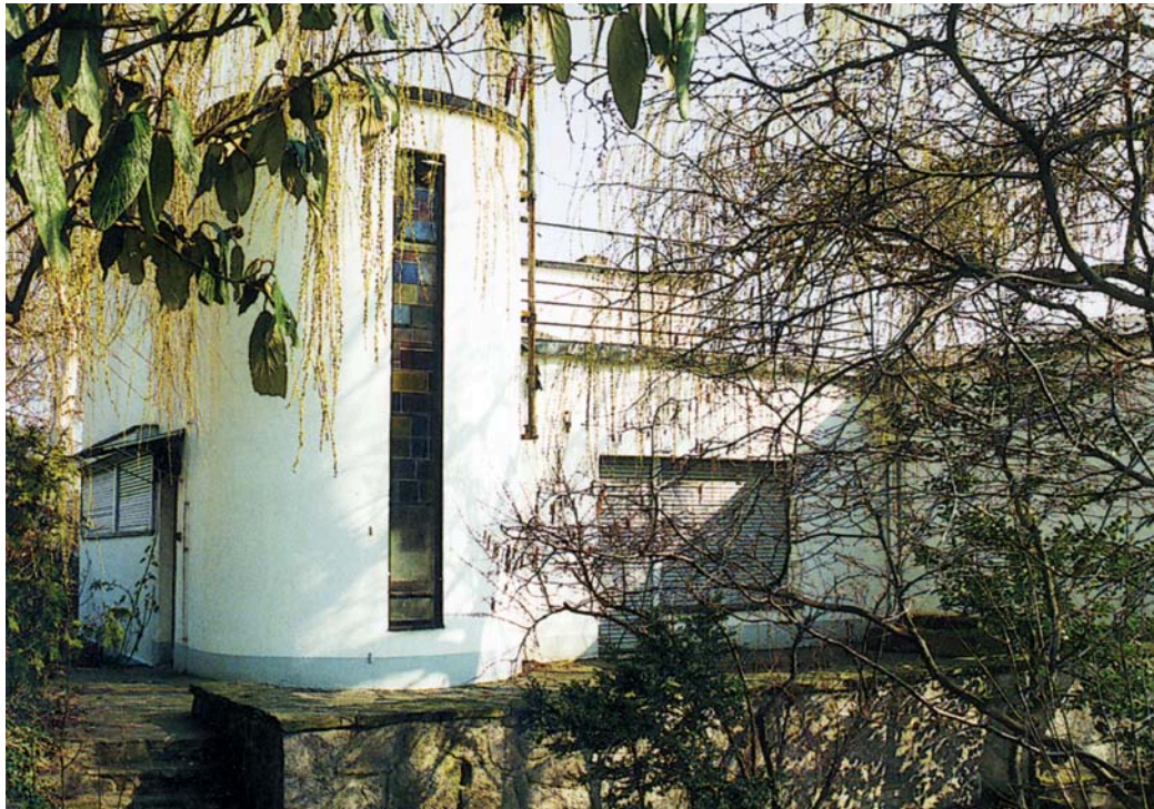
In den 1990er Jahren wurde das Haus Fieger saniert. (Foto: Wolfgang Thöner, 1995, Stiftung Bauhaus Dessau)
