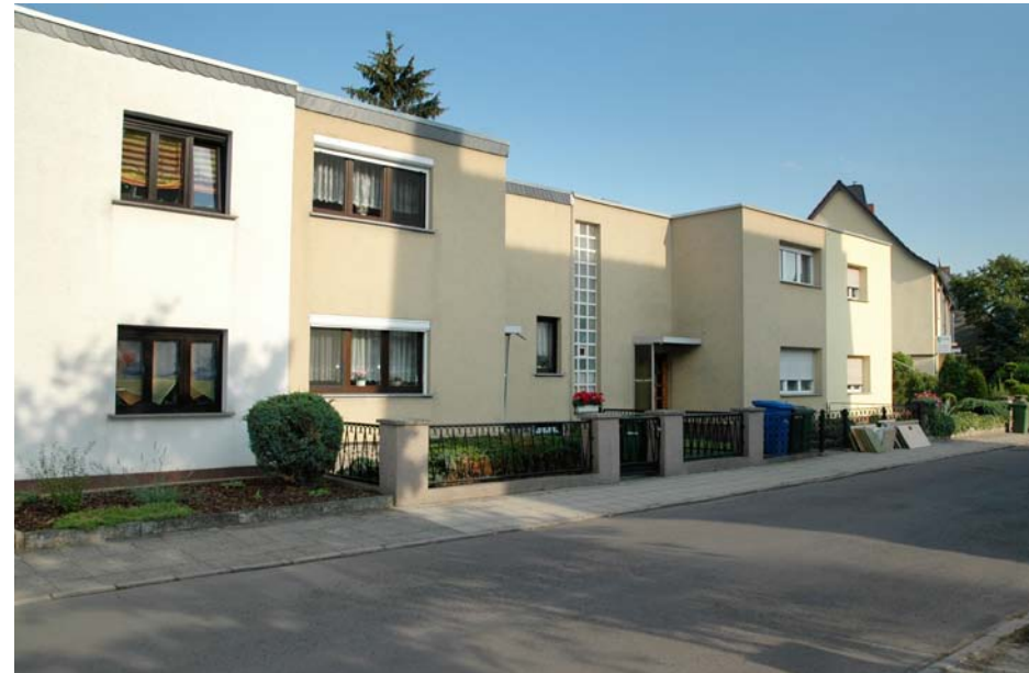
Walter Gropius: Sietö II, Ziegel, 2011. Die meisten Häuser von Gropius besteht es aus Schlackebetonsteinen, zwei Arbeiter fertigten die Steine auf der Baustelle im Akkord an – eine neue Verfahrensweise. Daneben gab es auch eine Reihe Ziegelbauten, die miteinander verglichen wurden. (Fotos: Ursula Achternkamp, 2011, Stiftung Bauhaus Dessau)
